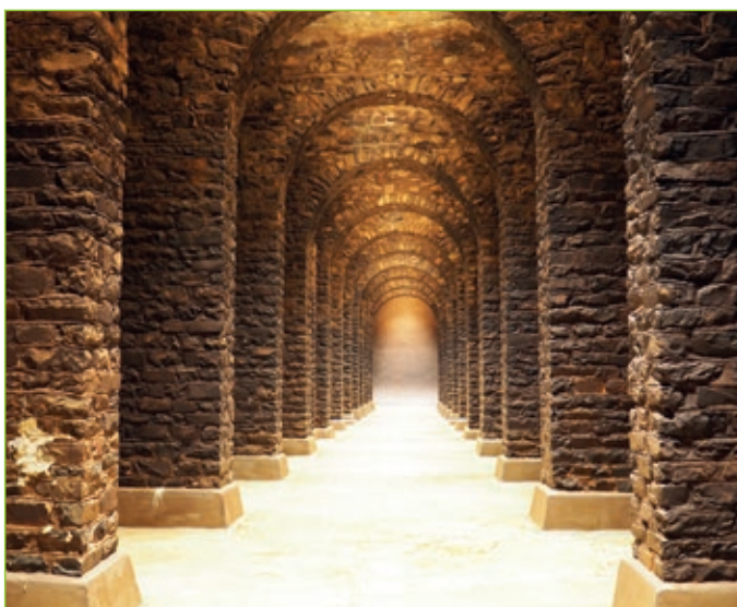
7 mètres sous terre, le réservoir des Gallêts.
